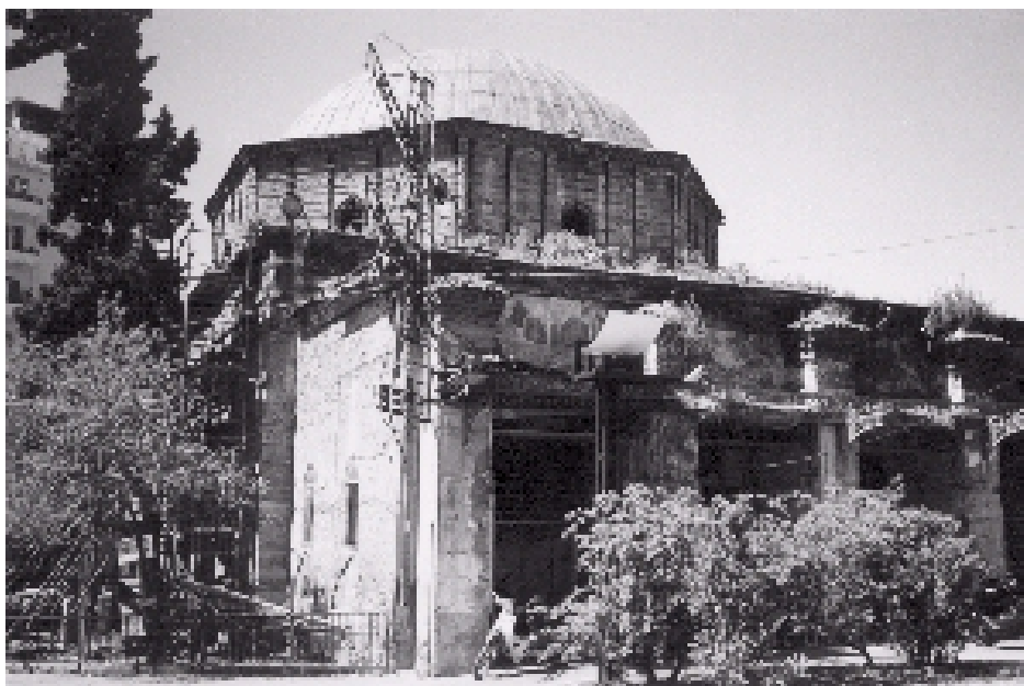
Εικόνα 16. Εξωτερική άποψη του τζαμί Χαμζά Μπέη. Πηγή: Τα παλιά Σινεμά < http://www.cinefilip.gr/gr_salonica_009_ALKAZAR.htm >
