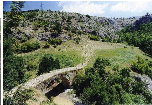
Εικόνα 5. Γέφυρα του Αλεξάνδρου
