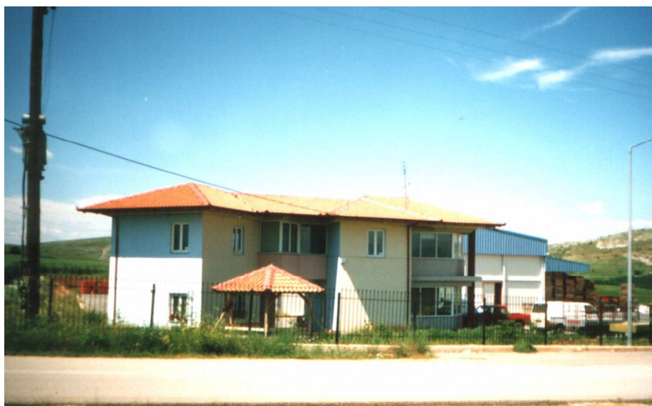
Εικόνα 10. Το κτίριο της διοίκησης και του λογιστηρίου.
