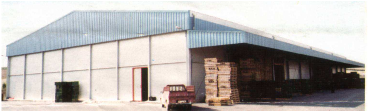
Εικόνα 7. Οι καινούριες ψυγειακές εγκαταστάσεις.
