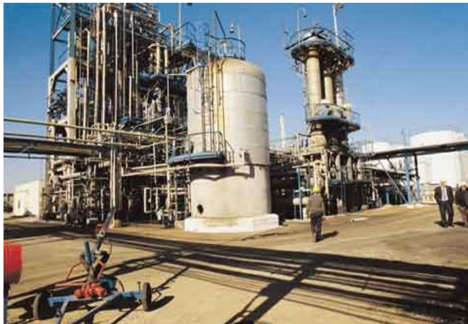
Εικόνα : Διυλιστήριο Πετρελαίου.
