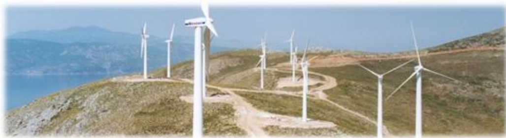
Εικόνα 6. Αιολικό Πάρκο . Πηγή: Eletaen
