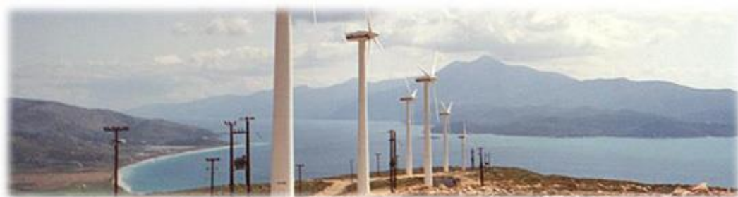
Εικόνα 7. Αιολικό Πάρκο. Πηγή : Eletaen.
