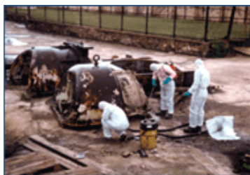
Εργασίες Αποκλεισμού χώρου πρώην ΑΗΣ Φαλήρου για την εξυγίανση του από τον Αμιάντο
