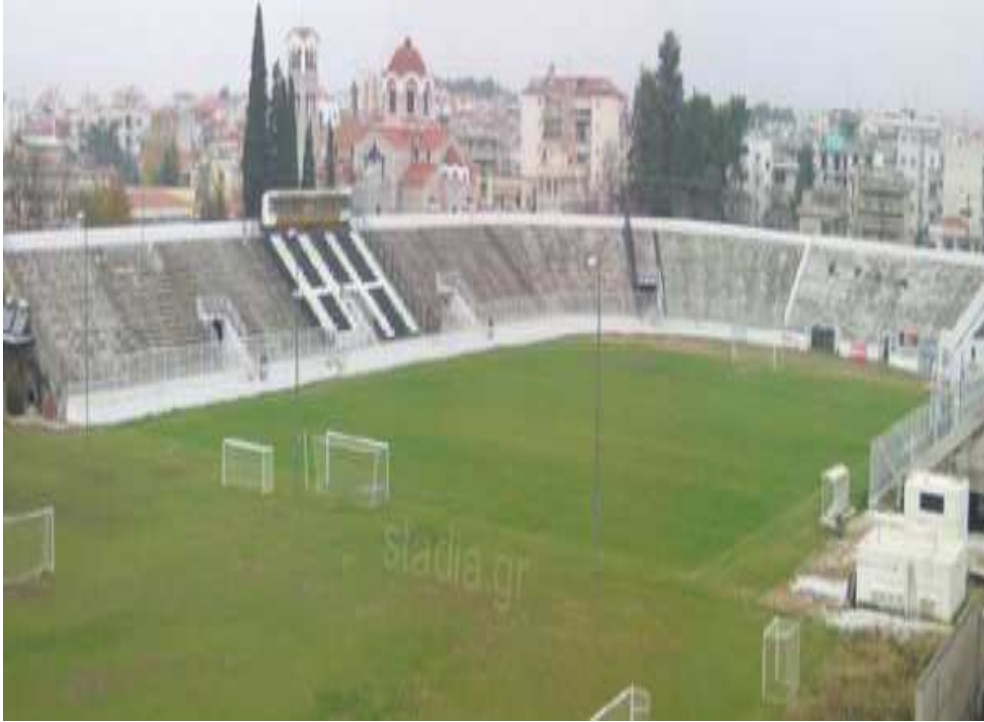
Εικόνα 15 Γήπεδο ΔΟΞΑΣ ΔΡΑΜΑΣ
