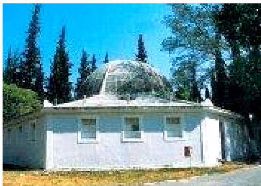
Εικόνα 6-8: Ανακατασκευή Τούρκικου Χαμάμ στο Σέδες Θέρμης. 122
