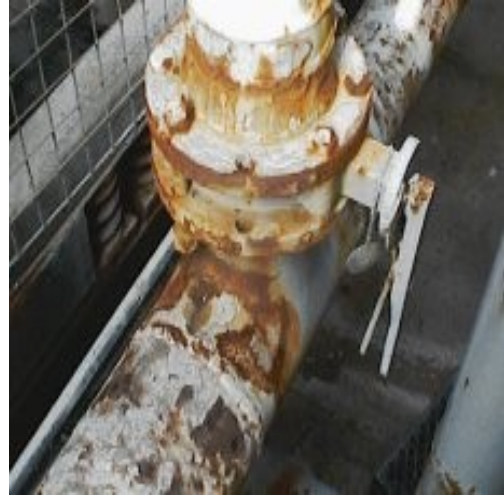
Φωτ. 1.12 Διάφορες μεταλλικές κατασκευές που υπέστησαν διάβρωση
