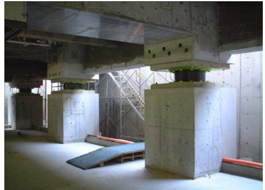
Ολοκλήρωση σεισμικής μόνωσης
