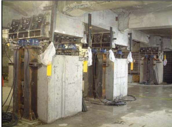
Προσωρινό σύστημα στήριξης Ολοκλήρωση σεισμικής μόνωσης
