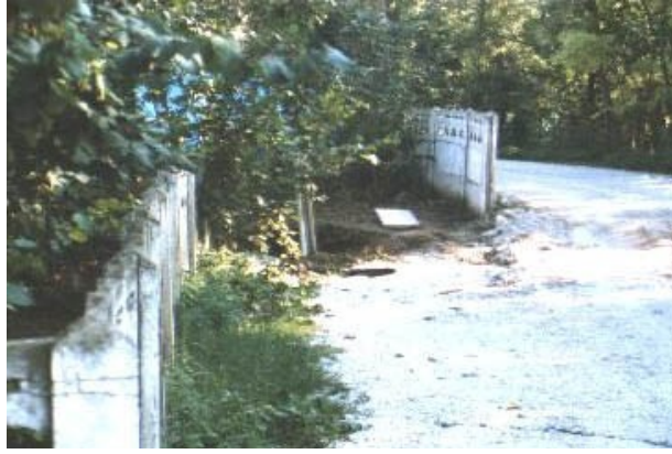
Οριζόντια μετάθεση φράκτη (στην περιοχή Sakaraya), κάθετου στο ρήγμα του σεισμού του Ismit της Τουρκίας (Νικομήδεια, 17.8.1999, M=7,5 )
