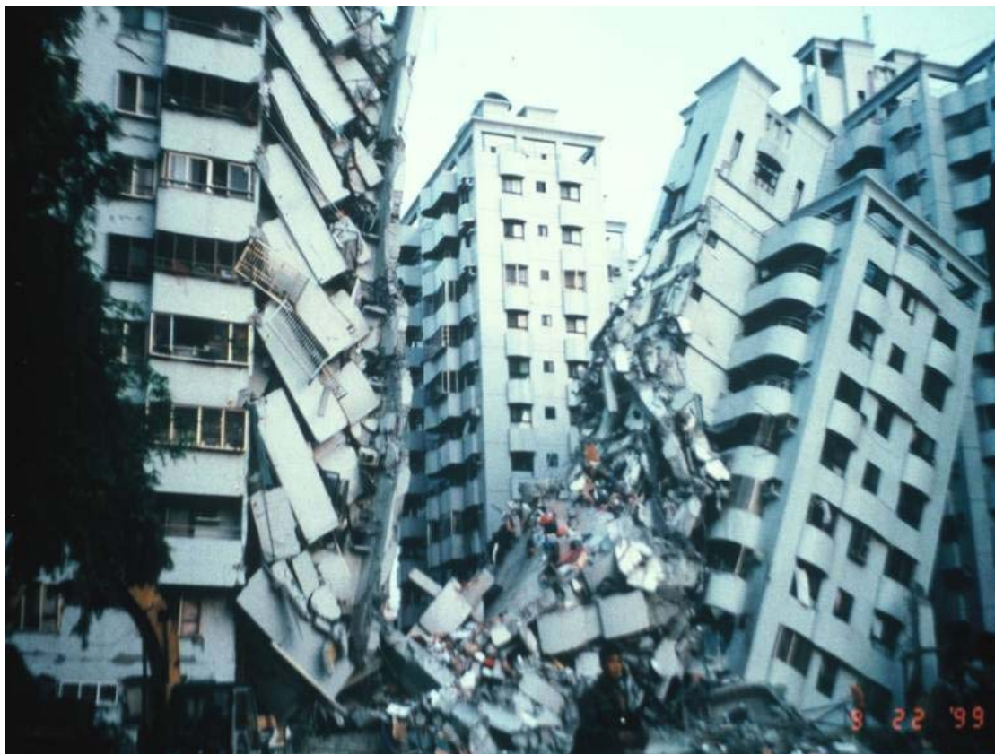
Βλάβες στις κατασκευές από το σεισμό στην Taiwan στις 21 Σεπτεμβρίου 1999 (M = 7.6).
