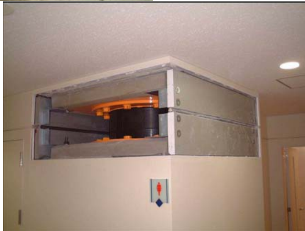
Τοποθέτηση μονωτήρα σε πυροπροστατευτικό πίνακα
