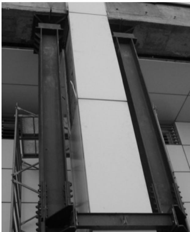
Τοποθέτηση προσωρινών υποστυλωμάτων
