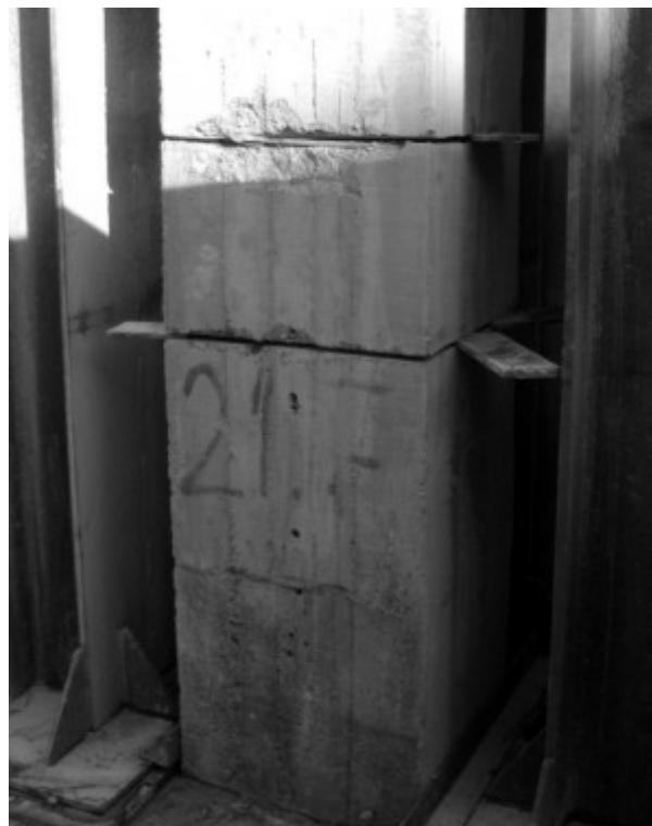
Κοπή υπάρχοντος υποστυλώματος
