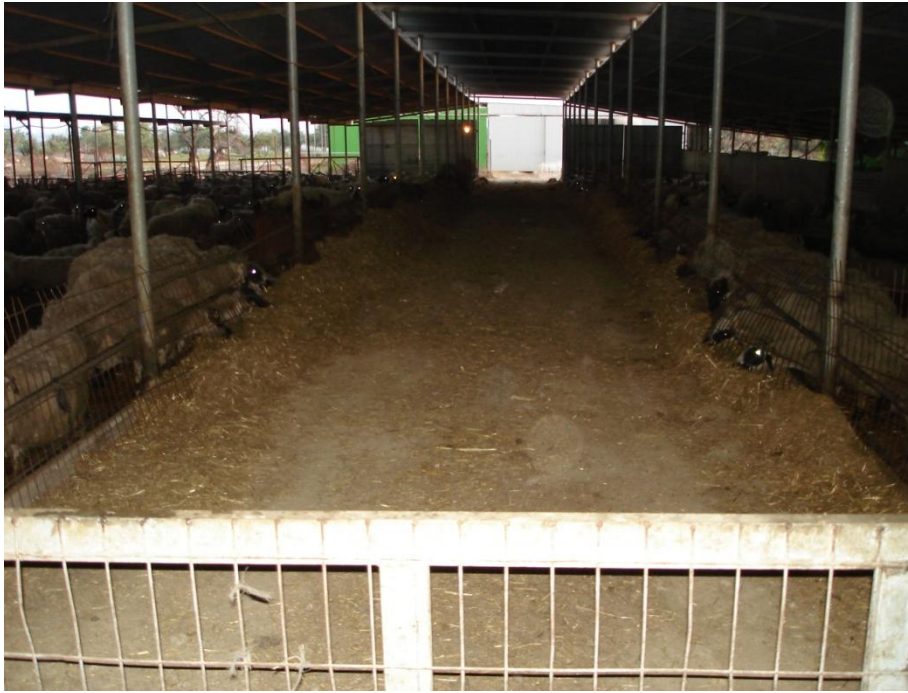
Εικόνα 3: Μεγάλος διάδρομος κυκλοφορίας και τροφοδοσίας
