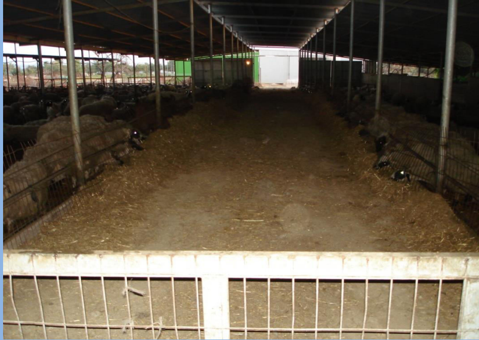
Εικόνα 3 :Μεγάλος διάδρομος κυκλοφορίας και τροφοδοσίας
