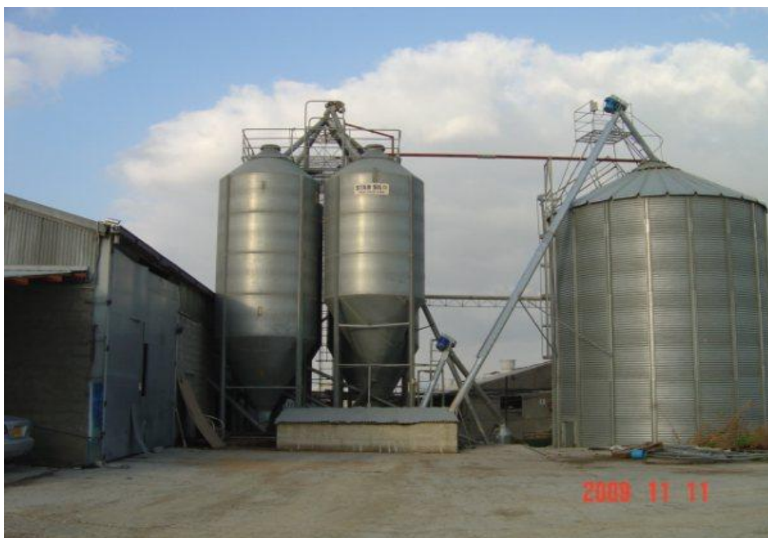
Εικόνα 10: Σιλό αποθήκευσης πρώτων υλών
