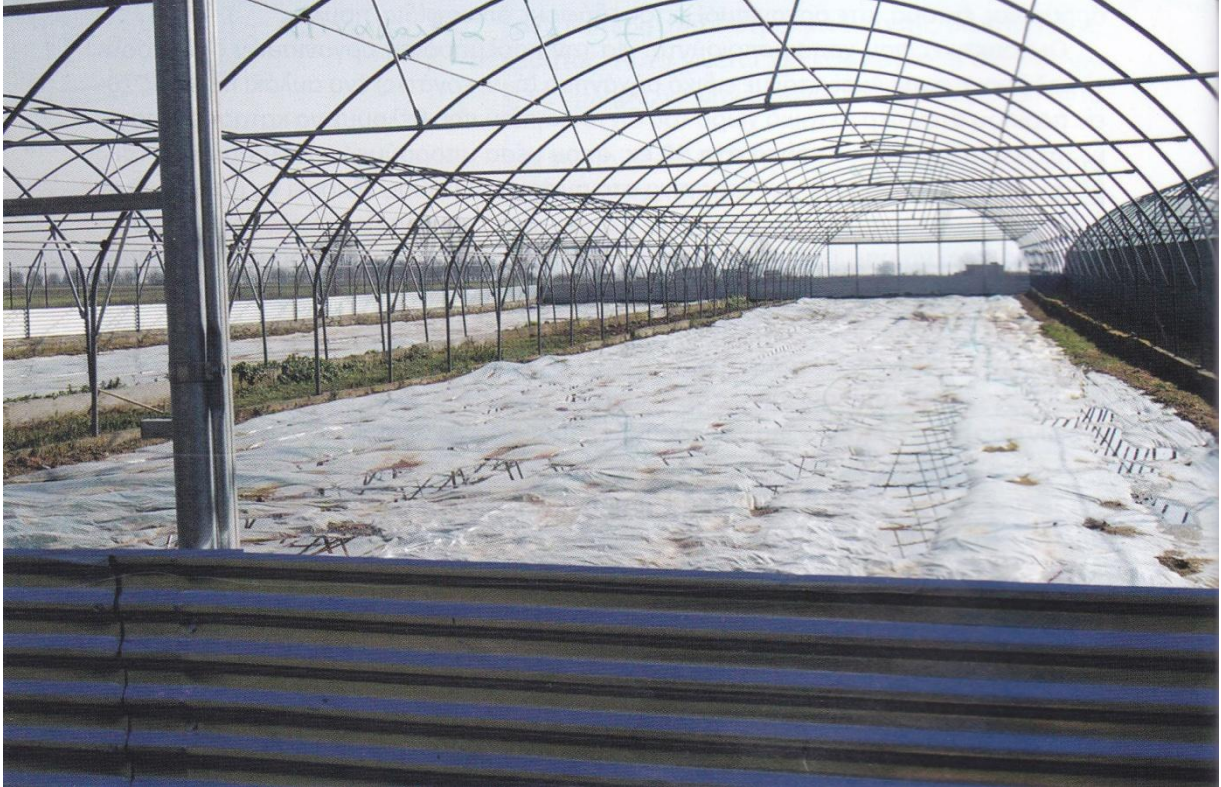
Εικόνα 22. Μεταλλική κατασκευή κλειστού τύπου (διχτυοκήπιο)
