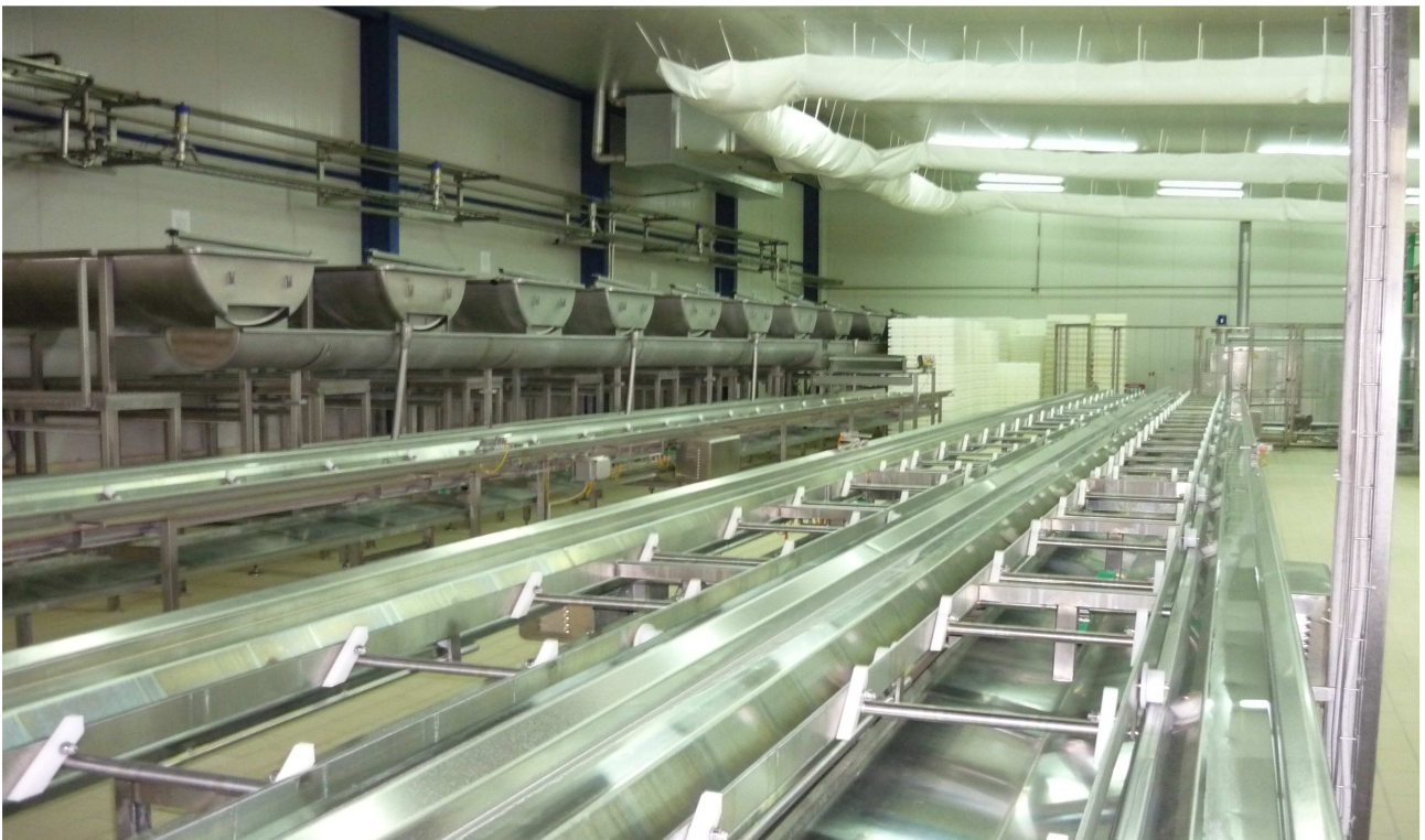
Εικόνα 36 χώρος τοποθέτησης καλουπιών
