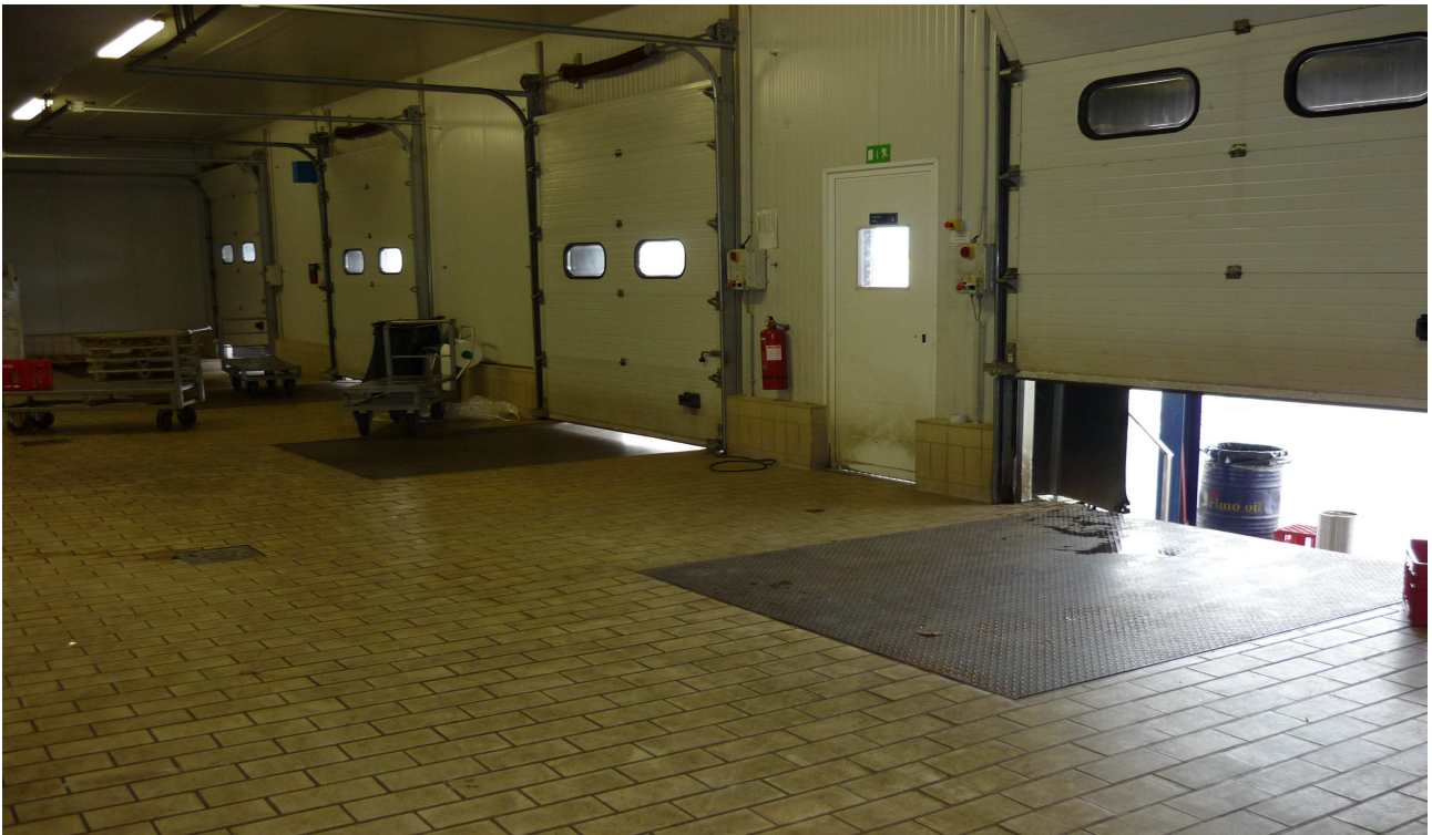
Εικόνα 46, 47 χώρος φόρτωσης τελικών προϊόντων
