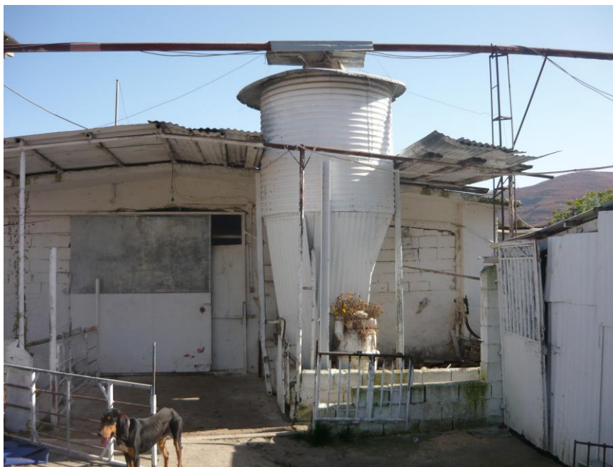
Εικόνα 14. Αποθηκευτικοί χώροι, σιλό στον προαύλιο χώρο.
