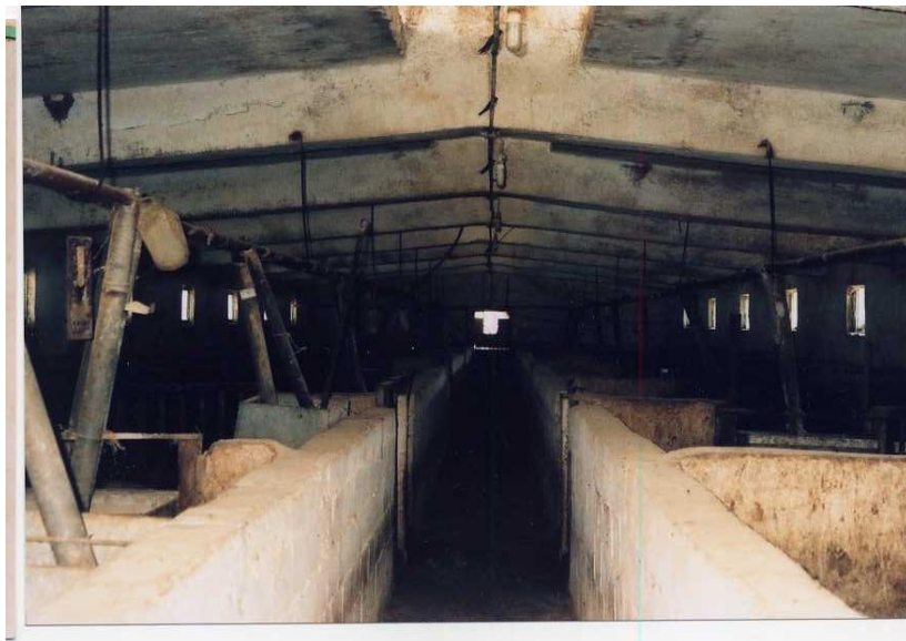
Εικόνα 6. Διάδρομος στο κτίριο προπάχυνσης και αριστερά – δεξιά τα κελιά.
