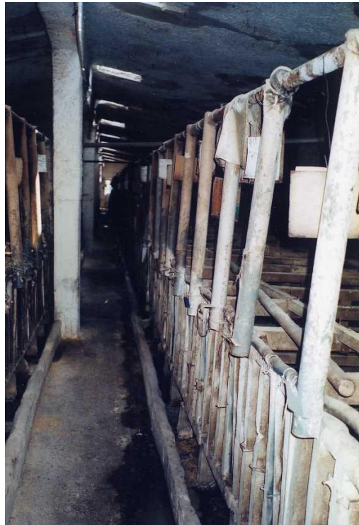
Εικόνα 10. Διάδρομος στο κτίριο ξηράς περιόδου.
