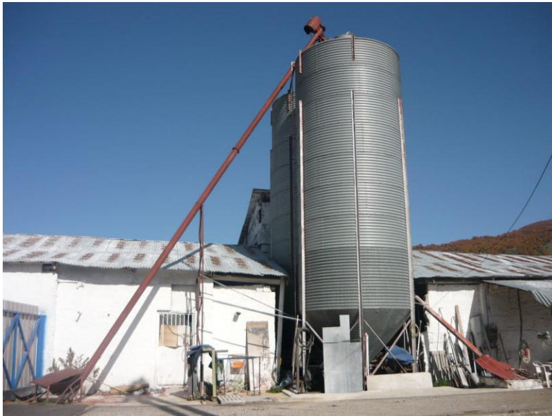
Εικόνα 11. Σιλός αποθήκευσης τροφίμων στον προαύλιο χώρο.
