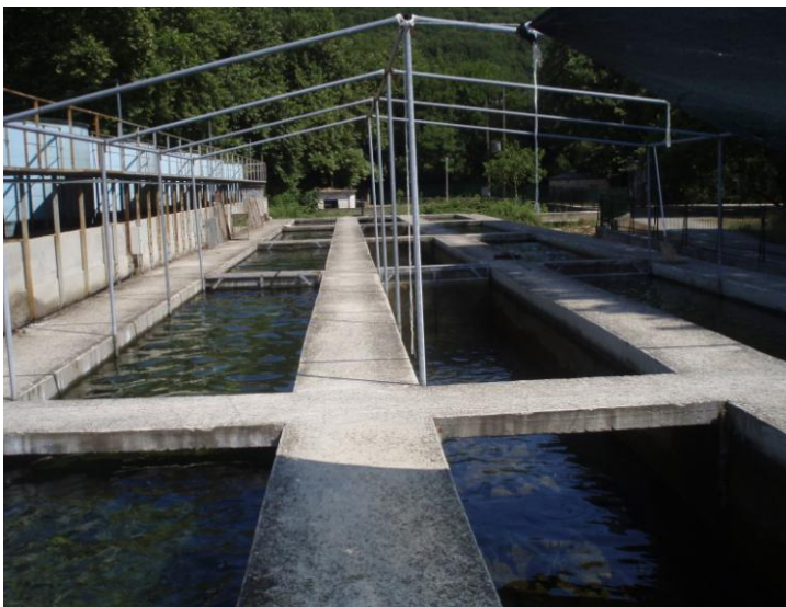
Εικόνα 19: Τσιμεντένιες δεξαμενές γεννητόρων στον Ιχθυογεννητικό Σταθμό Λούρου
