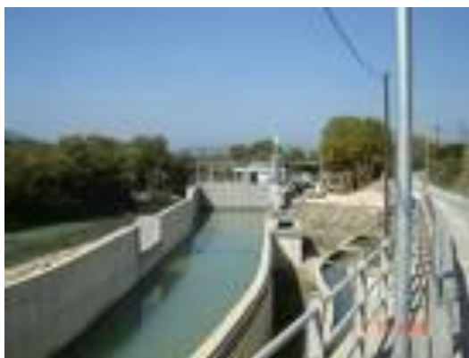
Εικόνα 9: Έργο υδροληψίας για την υδροδότηση ιχθυοτροφείου στο Λούρο
