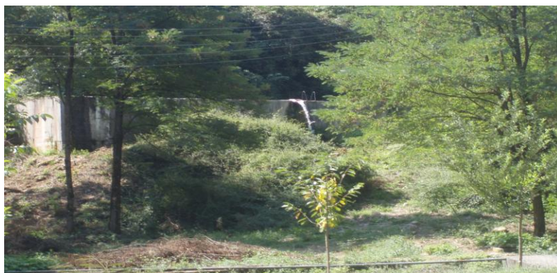
Εικόνα 8: Δεξαμενή νερού Ιχθυογεννητικού Σταθμού Λούρου
