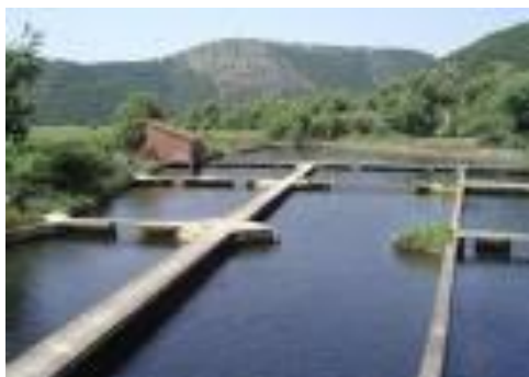
Εικόνα 56 : Δεξαμενές στο καπνιστήριο πέστροφας του Α. Τσιάλιου
