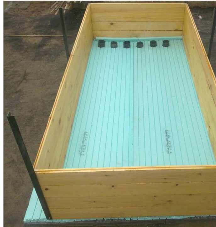
Φωτ.3.1 ,3.2 όψη της λεκάνης από πάνω, φαίνεται η βάση από μονωτικό υλικό ,και οι πλαστικοί σωλήνες καθώς και τα πλαϊνά τοιχώματα από ξύλο . Φωτ.3.3, 3.4 . όψη της λεκάνης από το πλάι, φαίνεται η βάση από πλακάκια πεζοδρομίου ,και πάνω από αυτά πλάκες από μονωτικό υλικό .
