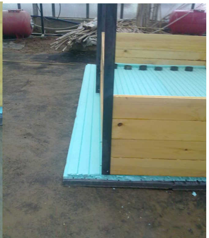
Φωτ.3.1 ,3.2 όψη της λεκάνης από πάνω, φαίνεται η βάση από μονωτικό υλικό ,και οι πλαστικοί σωλήνες καθώς και τα πλαϊνά τοιχώματα από ξύλο . Φωτ.3.3, 3.4 . όψη της λεκάνης από το πλάι, φαίνεται η βάση από πλακάκια πεζοδρομίου ,και πάνω από αυτά πλάκες από μονωτικό υλικό .
