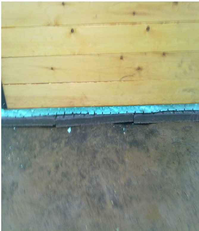
Φωτ.3.1 ,3.2 όψη της λεκάνης από πάνω, φαίνεται η βάση από μονωτικό υλικό ,και οι πλαστικοί σωλήνες καθώς και τα πλαϊνά τοιχώματα από ξύλο . Φωτ.3.3, 3.4 . όψη της λεκάνης από το πλάι, φαίνεται η βάση από πλακάκια πεζοδρομίου ,και πάνω από αυτά πλάκες από μονωτικό υλικό .
