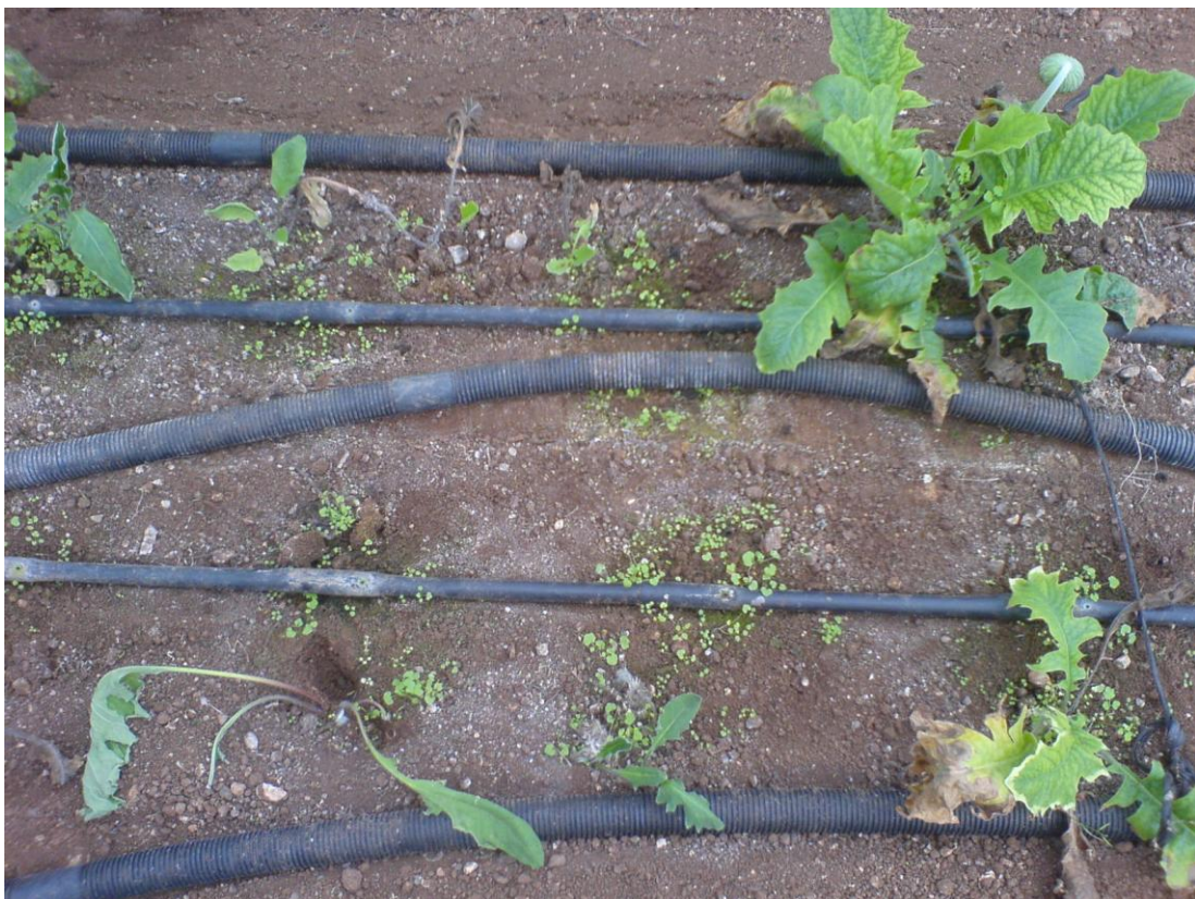
Εικ. 9 Σωλήνες θέρμανσης ( πηγή: Σφόλκου Μαρία )
