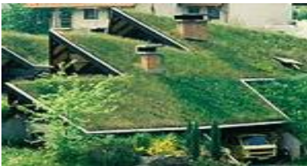
Εφαρμογή φυτεμένου δώματος σε υπόγειο γκαράζ
