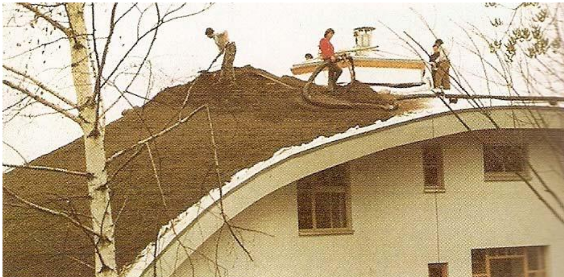
Διαμόρφωση φυτεμένου δώματος πάνω στη στέγη
