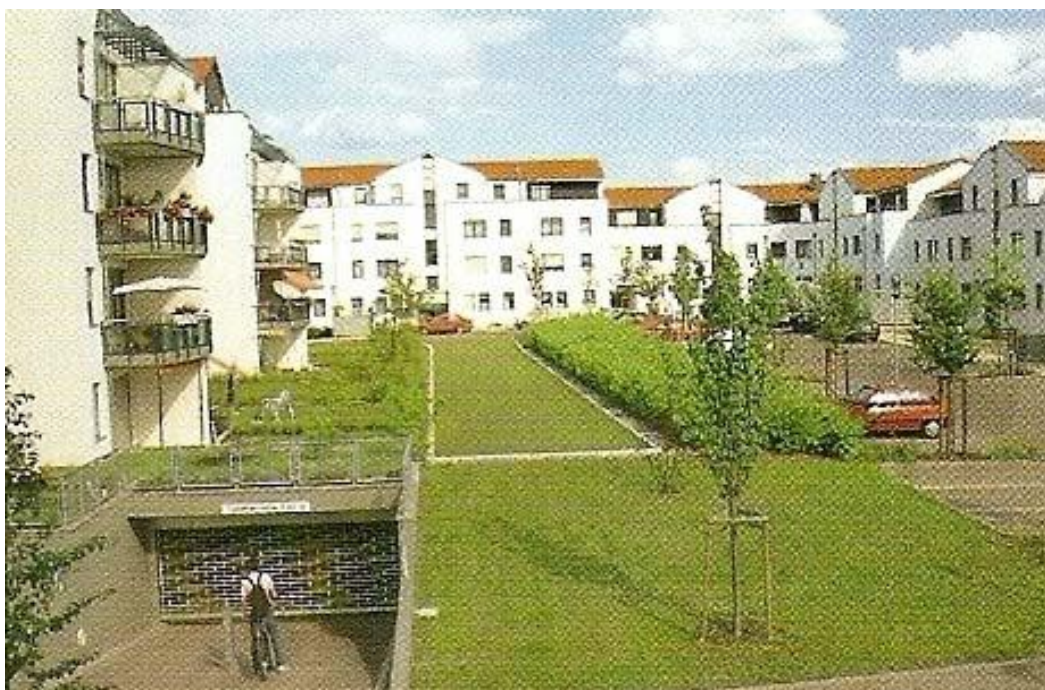
Εφαρμογή φυτεμένου δώματος σε χώρο στάθμευσης
