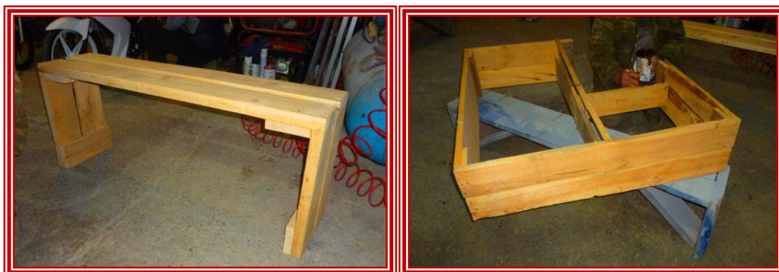
Εικ. 70 Κοπή και συναρμολόγηση των κατασκευών (Πηγή: Μ.Σ.)
