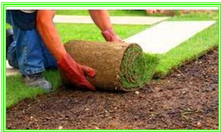
Εικ. 48 Τοποθέτηση έτοιμου χλοοτάπητα (Πηγή: διαδίκτυον)
