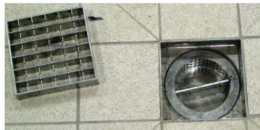
Εικόνα 5.1. Συστήματα φρεατίων που υπάρχουν σε πολλά Catering.
