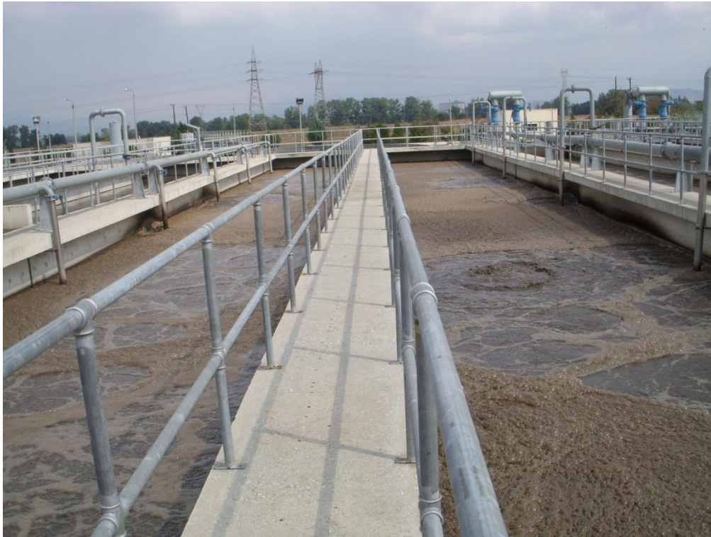
Σχήμα 1. Αερόβιος Βιολογικός Καθαρισμός (Δεξαμενή Αερισμού)
