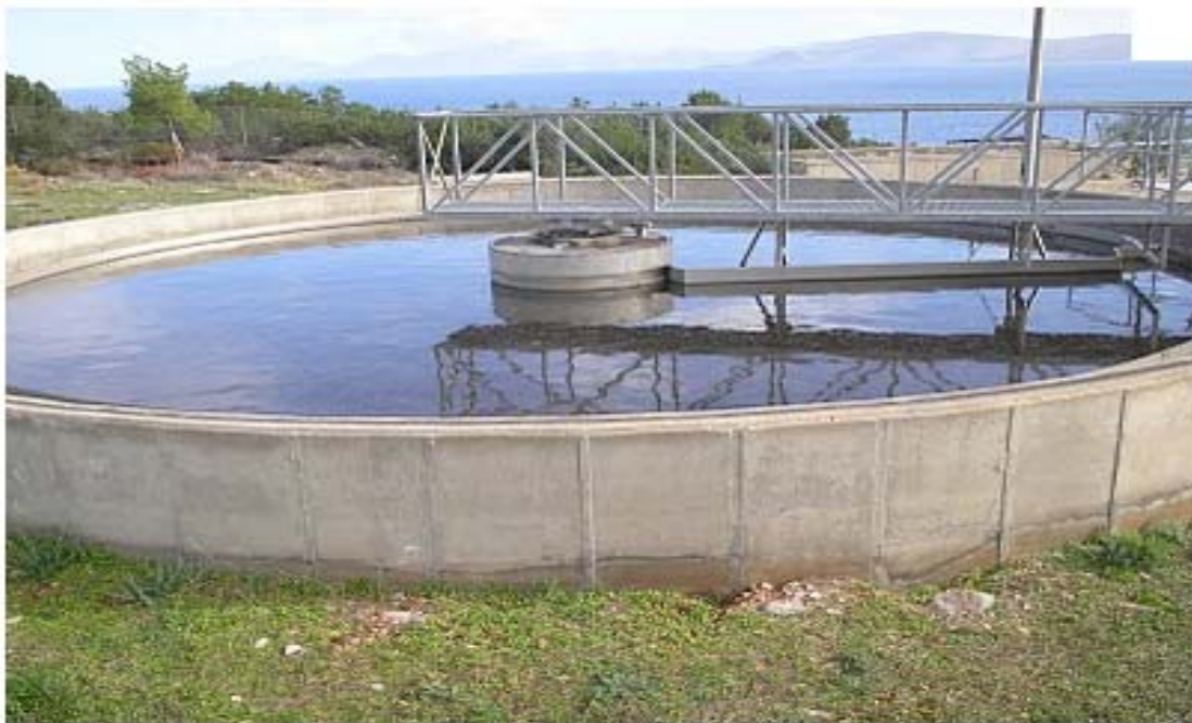
Σχήμα 1. Δεξαμενή καθίζησης σε μονάδα βιολογικού καθαρισμού.
